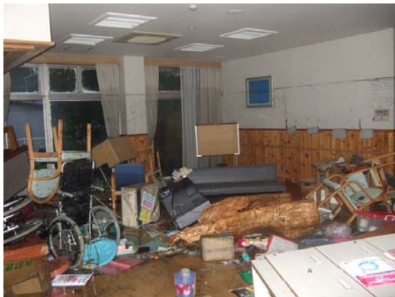
室内の被害状況
