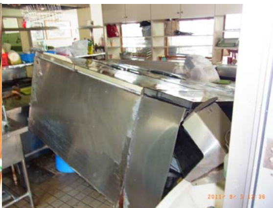
室内の被害状況
