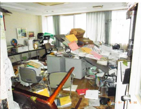
室内の被害状況
