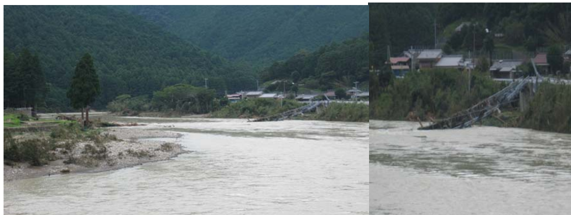
町道 下蔵土吊橋
