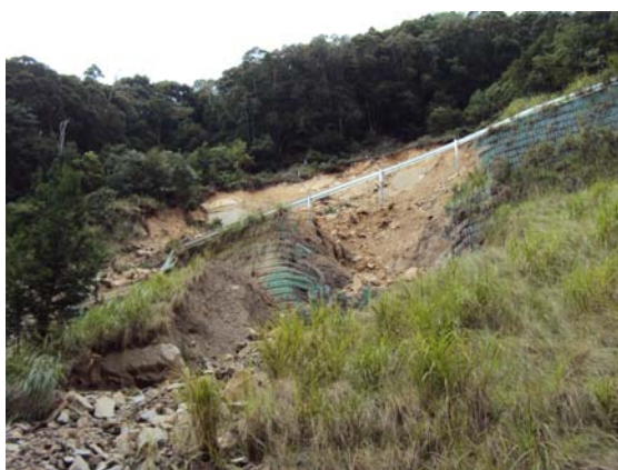
林道 高原谷線（道路流出）
