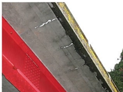
鋼材の腐食
