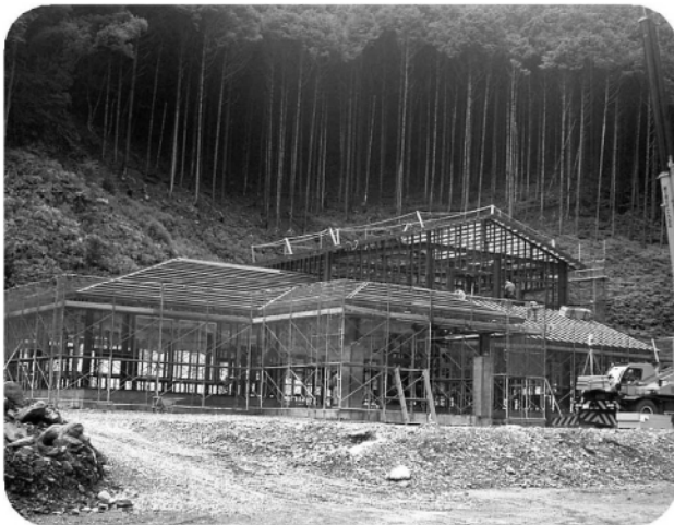
建設中の火葬場（鶴川）
