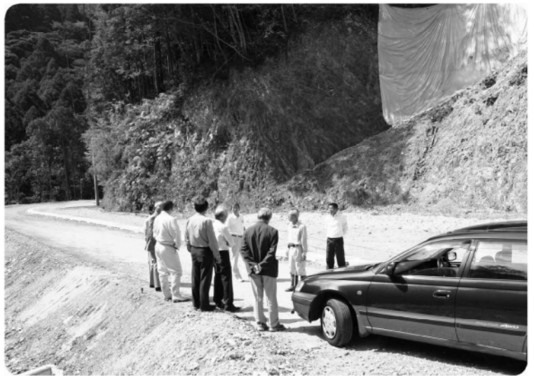
町道下露小川線の改良状況を視察(9月24日)
