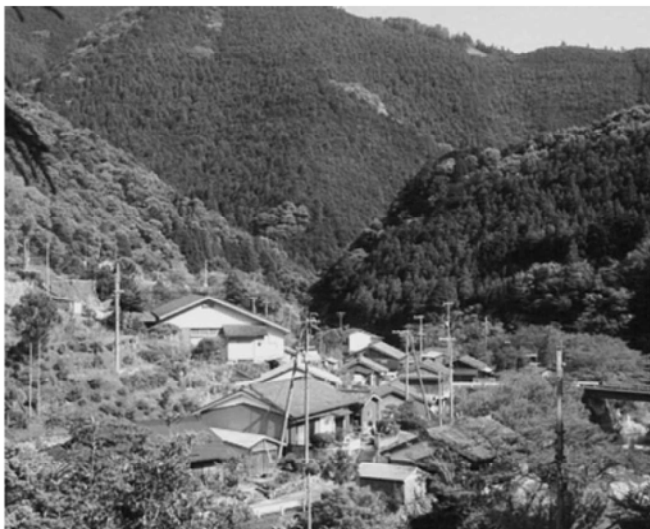
携帯電話通信用鉄塔が整備される松根地区
