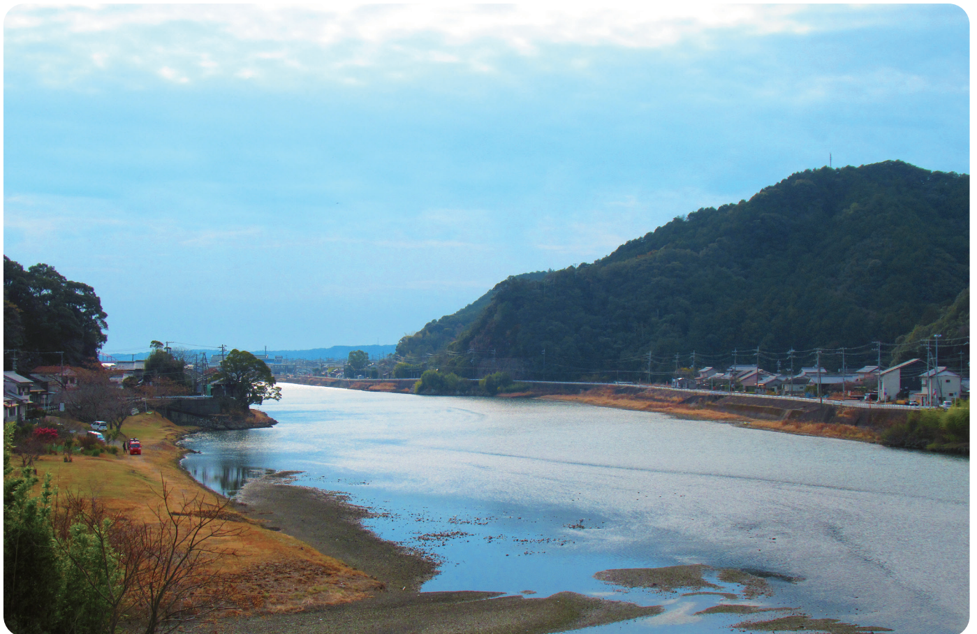
工事前の現況
