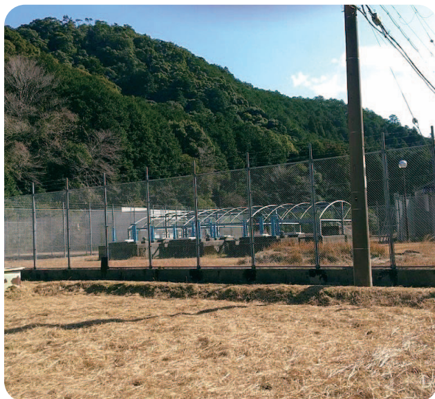
簡易水道施設
