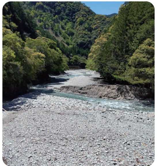
松根砂防ダムの上流
