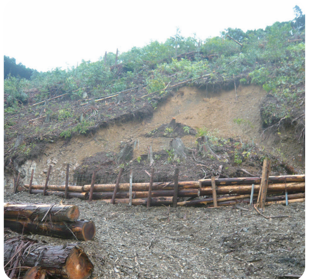
三尾川伐採現場
