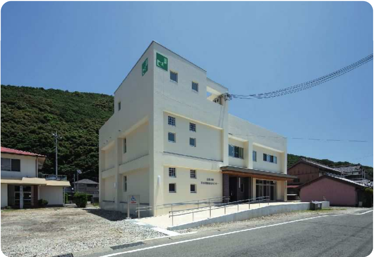
完成した津波避難総合センター（高池）
