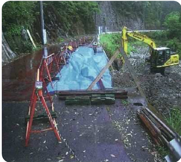
添野川災害復旧工事
