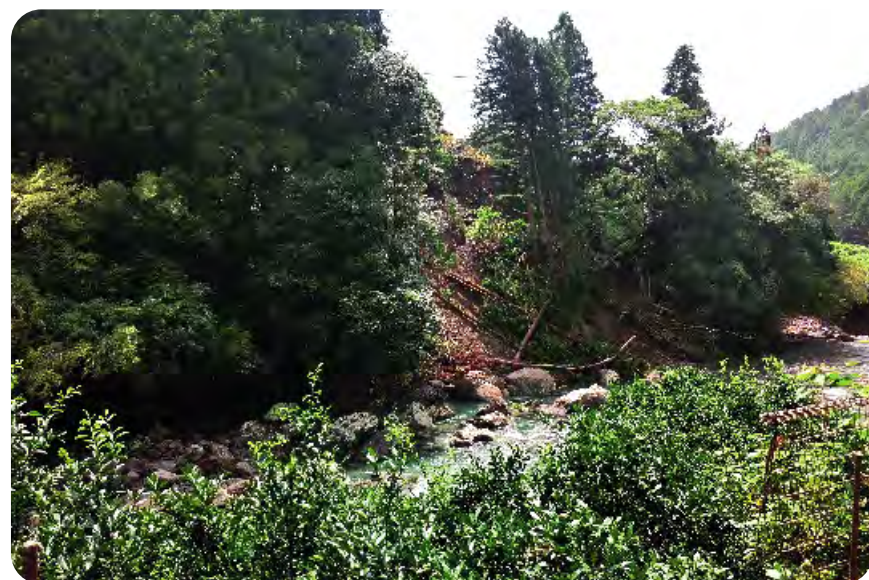
平井の被災現場（台風20号襲来後に撮影）
