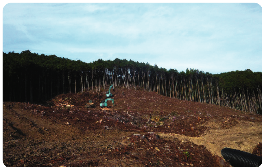
三尾川の工事現場
