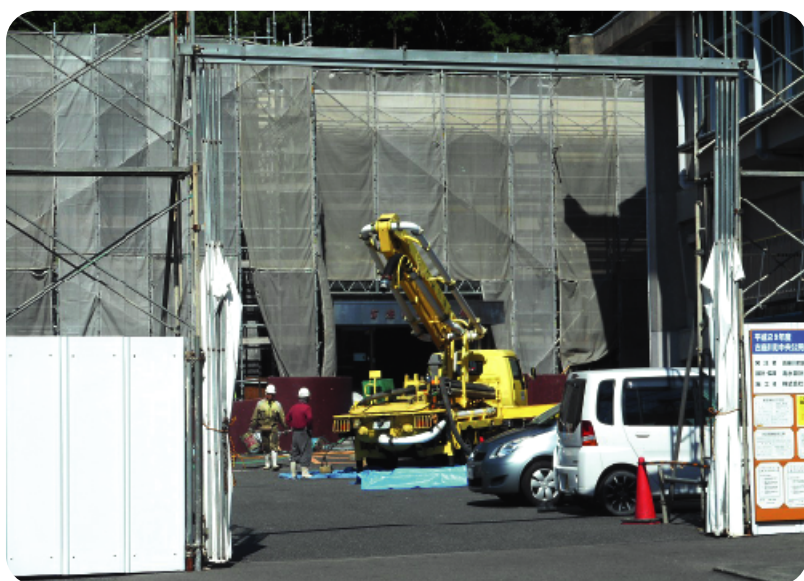
改修中の中央公民館
