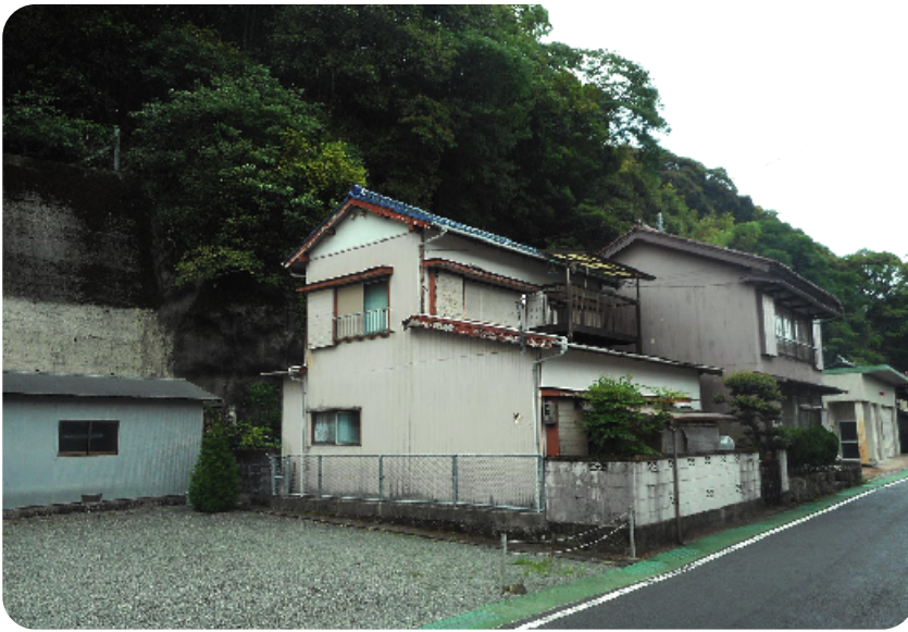
防災対策治山工事（高池）
