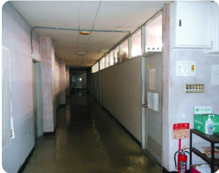
改修が予定される役場2階
