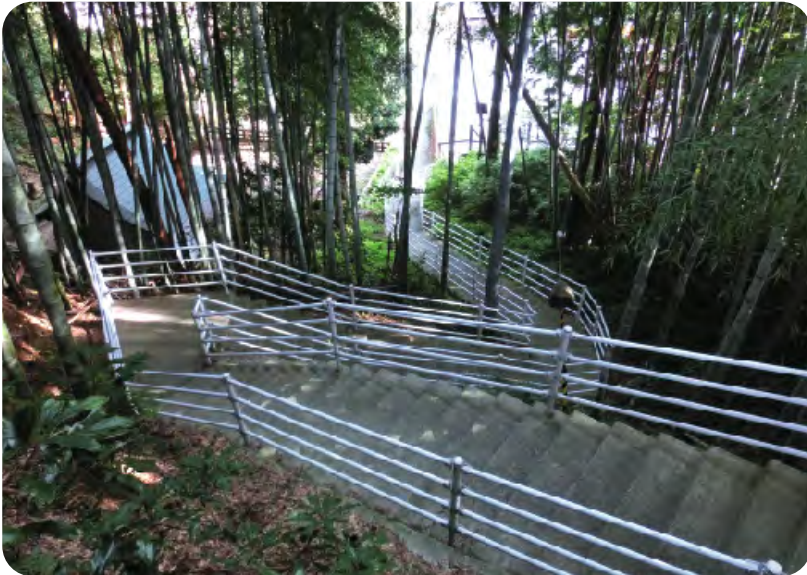
既に整備された避難路 (高池上部)
