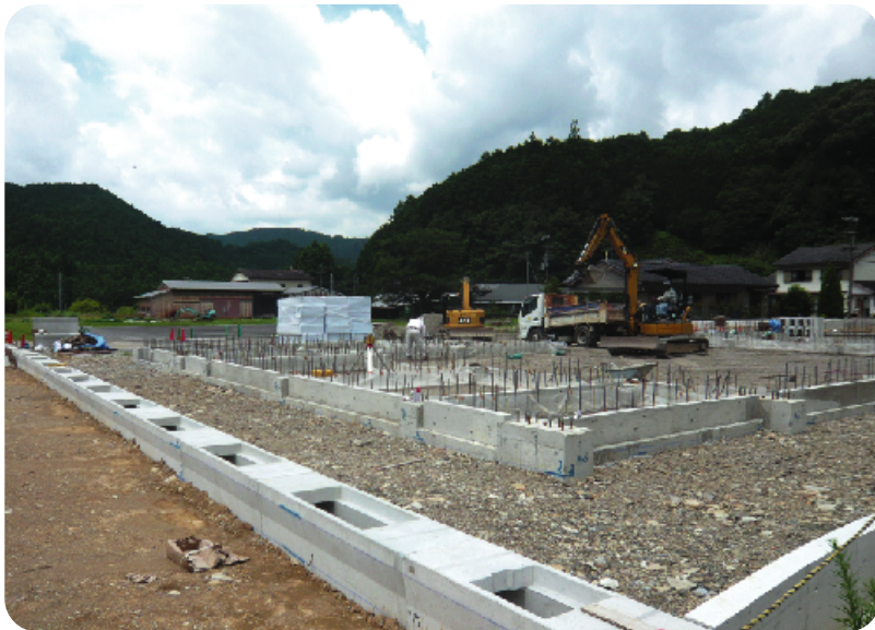
建設中の七川総合センター(仮称) (下露)
