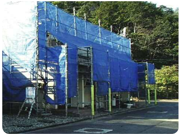
改装工事中の明神団地
