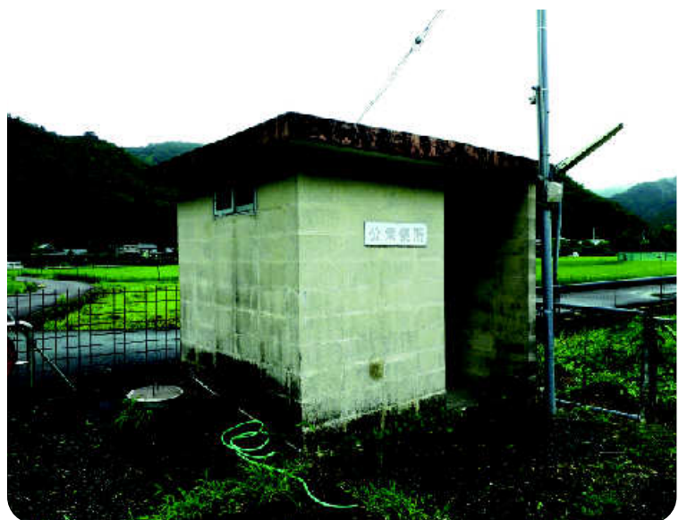
直見の公衆トイレ
