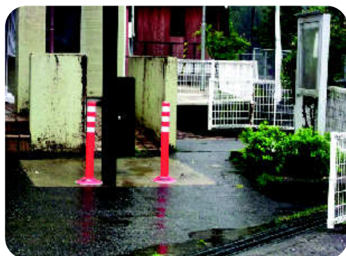
通せん坊している誘導灯
