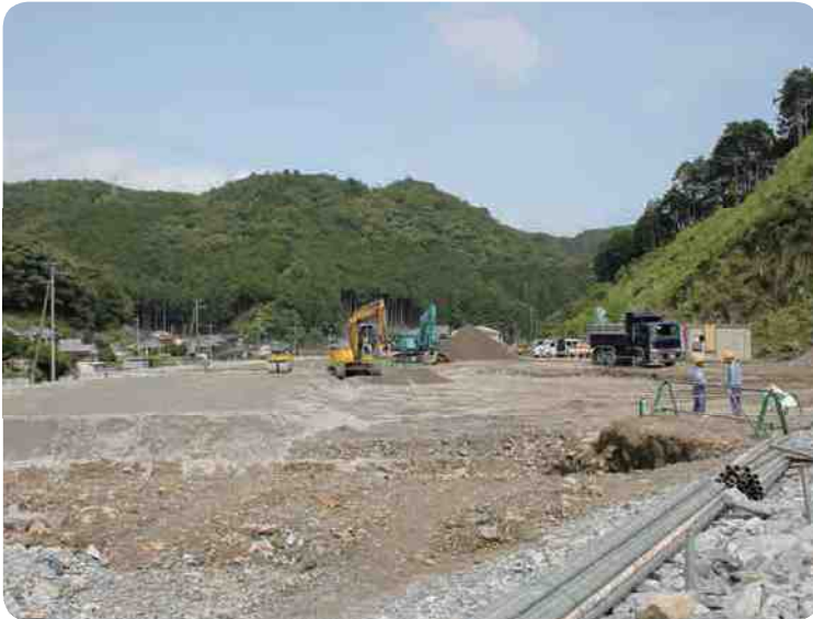
工事中の川口団地
