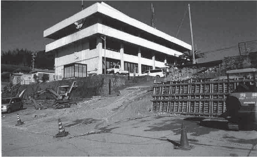
役場昇降路の災害復旧工事
