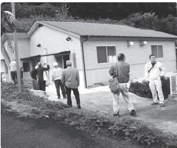
日高川町解体処理施設
