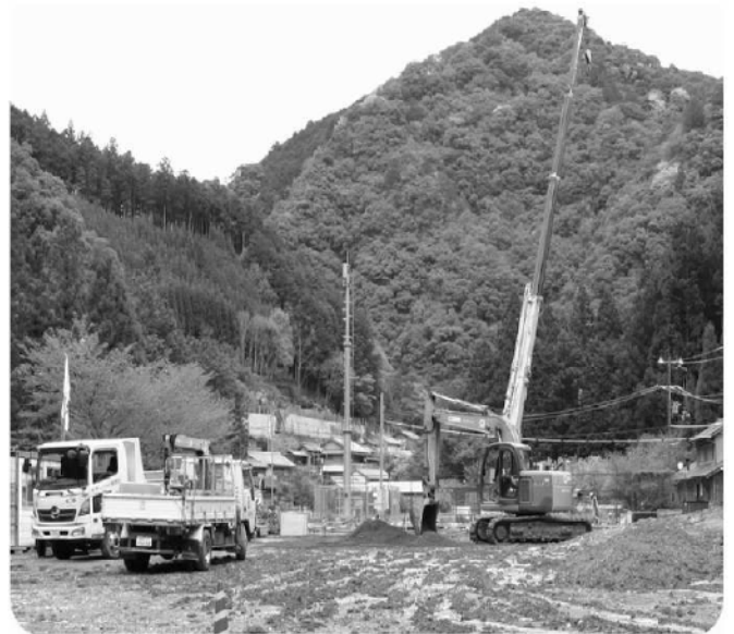
建設中の小川総合センター（仮称）
