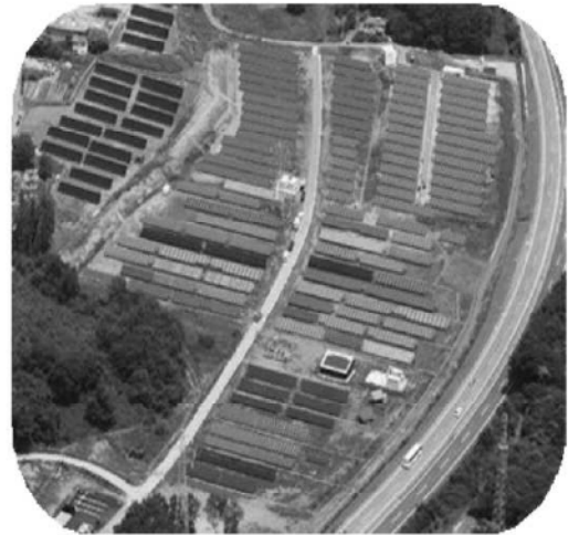
NEDO：大規模電力供給用太陽光発電系統 安定化等実証研究（山梨県） 「無断転載禁止」
