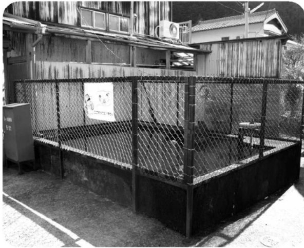
高池寺町の防火水槽
