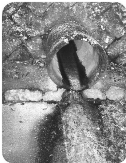
既設のヒューム管（高池下部）
